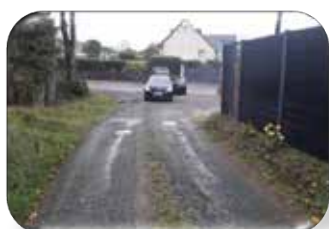
Voirie (Réseaux rue de l'Armor, avenue Pierre Loti, Crech an Herven, rue des Hortensias...)
